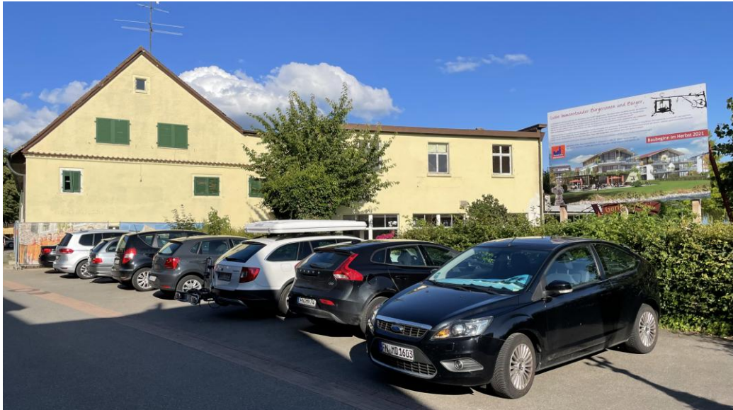
Blick von Osten auf das Hotel – Gasthof `Schiff`, im Vordergrund ca. 10 Pkw-Stellplätze, die direkt an der Straße angeordnet sind.
