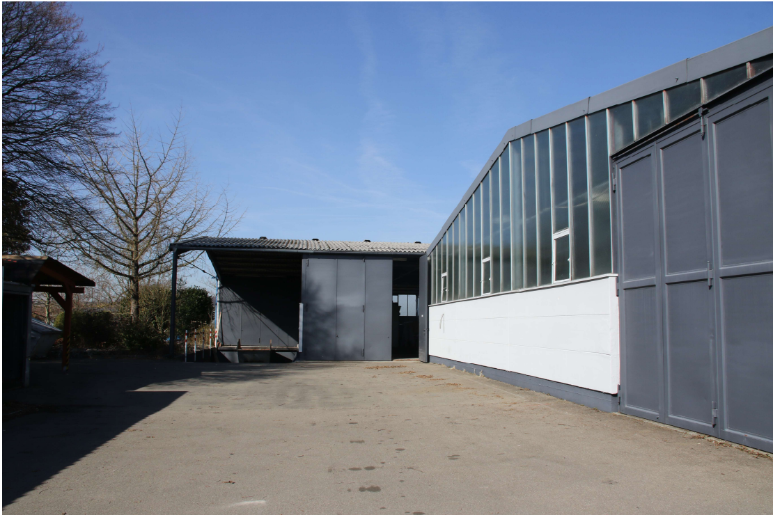
Abbildung 1: Produktionshalle mit Glas- und Blechelementen. Abb. vom 26.02.2019, Ramos.
