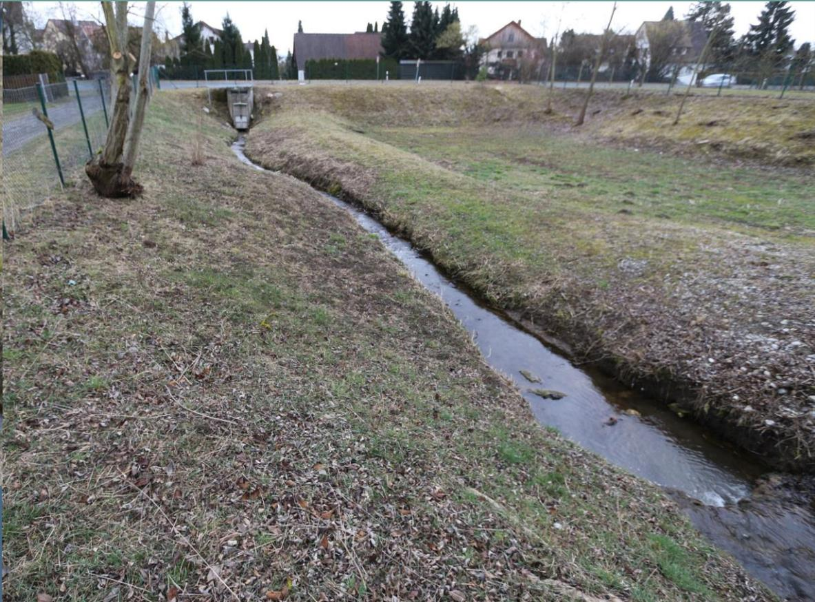
Becken entspricht nicht der DIN 19700 für Hochwasserrückhaltebecken
